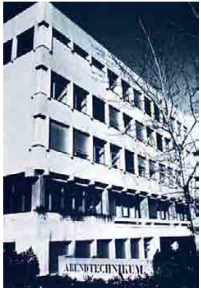
Der Neubau der Gewerbeschule (ab 1969) in Chur verbessert die Raumsituation markant.
