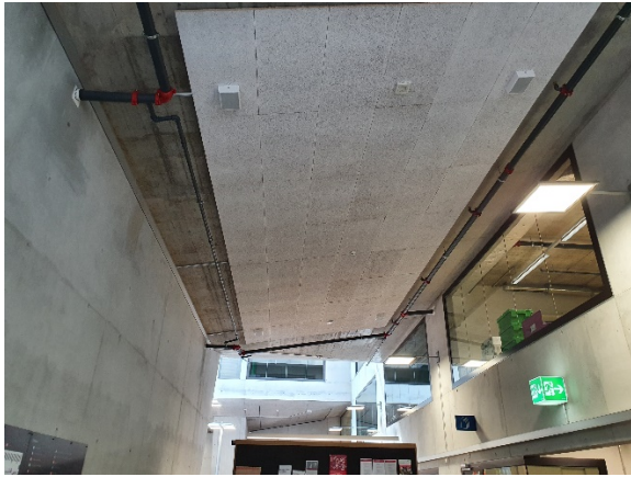
Abbildung 2: Plattenresonatoren an der Decke der Bibliothek von Roll (eigene Darstellung).
