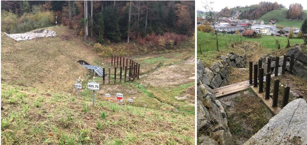
Abbildung 25a/b: Beispiele von Flächenschutzmassnahmen: Rückhaltebecken Rickenbach (links), Gesschiebesammler am Rüdélgraben (rechts)
