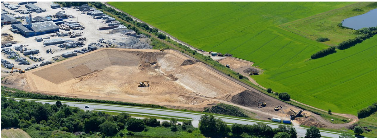
Erdbeckenspeicher Vojens (DK) 200'000 m 3 - ca. 2.6 Mio € gl.ramboll.com 23 €/m 3
