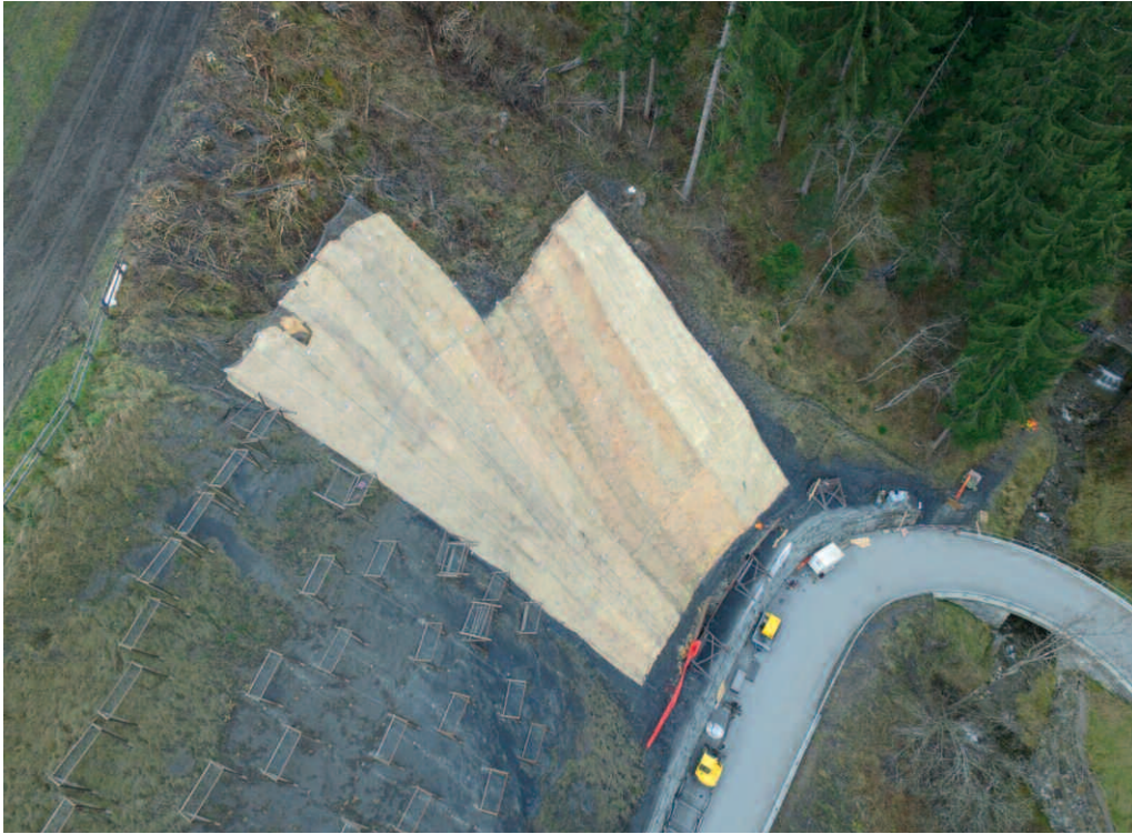
Die Holzwolle wird an der steilen Testfläche in Cazis GR ausgelegt.
