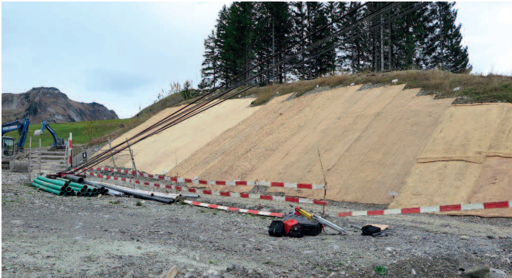
Die Begrünung der Testfläche in Stooz SZ wird mit Holzwollematten vorbereitet.
