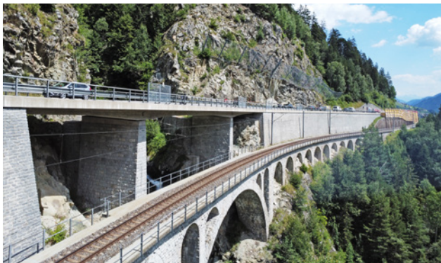
Abb. 1: Lehnenviadukte / Stützmauern entlang der Kantonsstrasse / Bahnlinie als Träger für vertikale Solaranlagen
