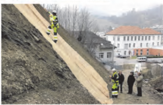
» Mit Holzwerkstätten an einem Waldrand in Wattwil betriebl. Arbeiter Holzwerkstätten als Erosionsschutz.
