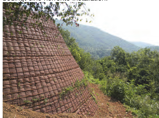
Abb. 4.16: Stützbauwerk aus bewehrter Erde Corndo/Italien
