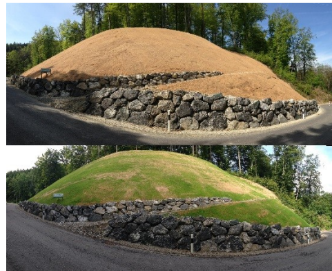
Abbildung 12: Böschung mit Holzwole geschützt
