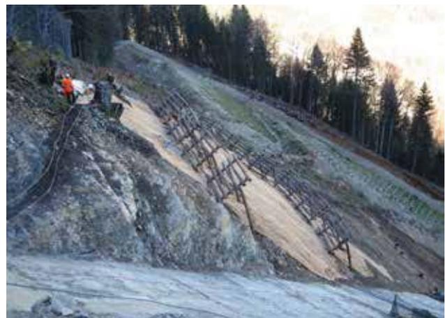
Gemeinsam mit der SBB AG wurde eine Testfläche an einer Böschung eines neuen Dammkörpers in der Gemeinde Gretzbach eruiert. Die Böschung wurde mit einer 15 cm dicken Humusschicht bedeckt. Darauf wurde die Holzwolle installiert.
