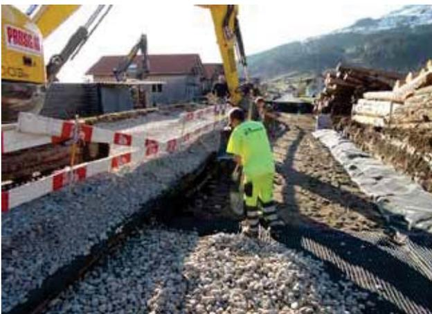
Filtern mit Bändchengewebe, Bildquelle SYTEC Bausysteme AG
