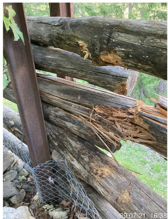
Abb. 3 Schäden an der Rundholzkonstruktion durch Steinschlag
