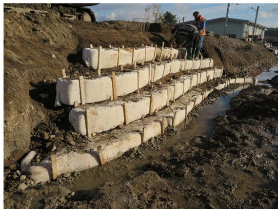
Abb. 1 Installation von Holzwolle-Faschinen in Stabio (TI)
