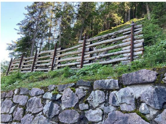
Abb. 2 Die Schutzpalisaden wurden bis an ihre Belastungsgrenze belastet.
