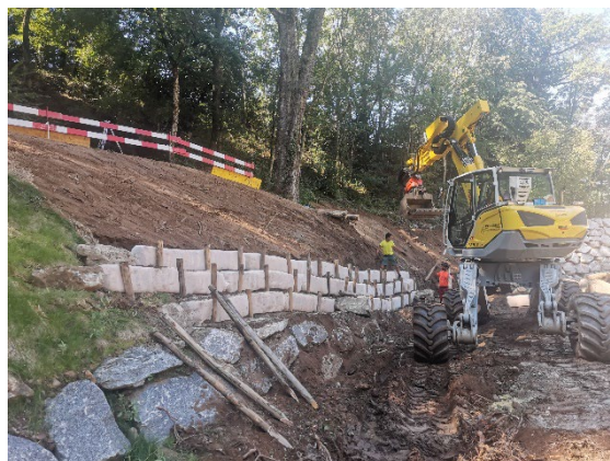
Abbildung 1: Installation der Holzwolle-Faschinen in Cadempino (TI)
