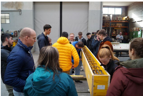
Abbildung 12: Vorbereitung zum Betonieren
