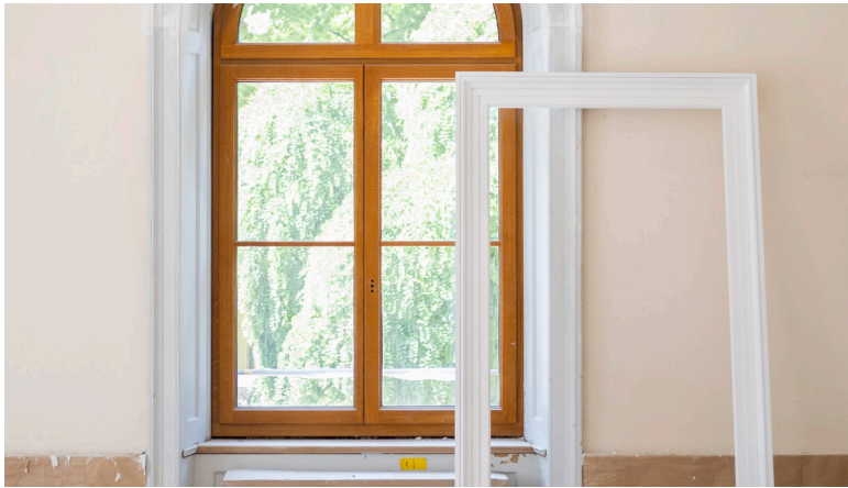
Baustellenbesichtigung Obergericht Chur, 2025
