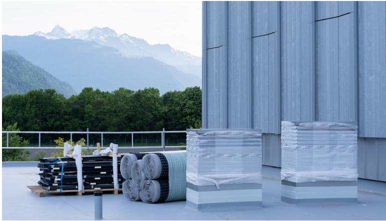
Baustellenbesichtigung Eventhalle Areon Chur, 2026
