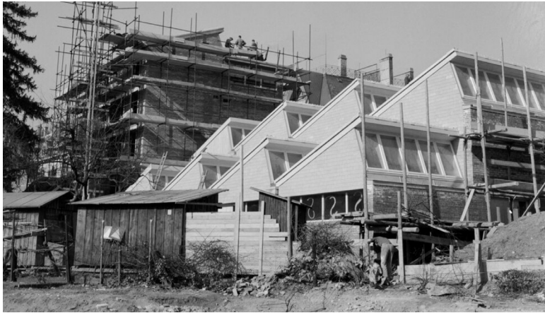
Ansicht der Baustelle Wuhstrasse in Zürich von Osten, 1954, Fotograf unbekannt (gla Archiv)
