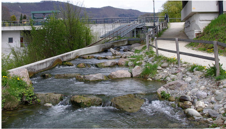
Fischtrappe Kraftwerk Wettingen
