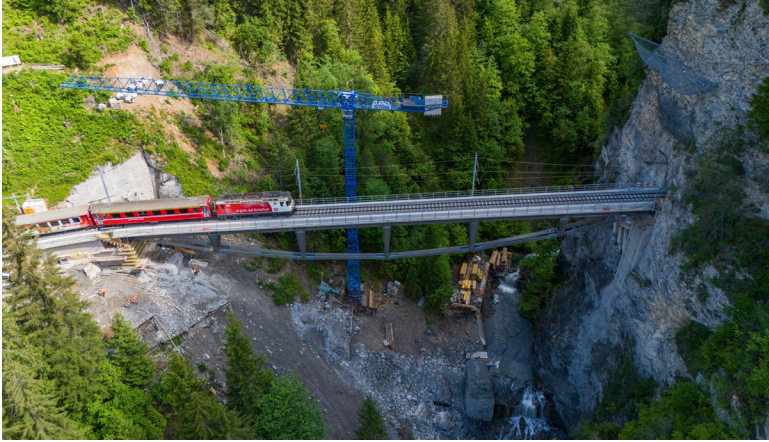
Rhätische Bahn, Ersatz Castielerviadukt
