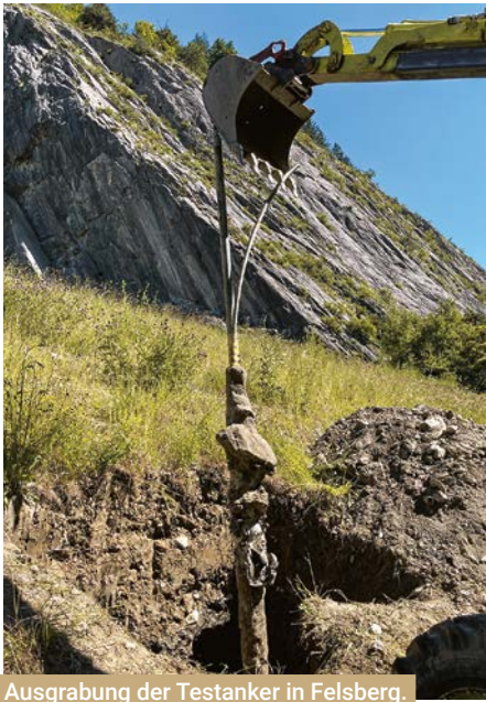
Ausgrabung der Testanker in Felsberg.
