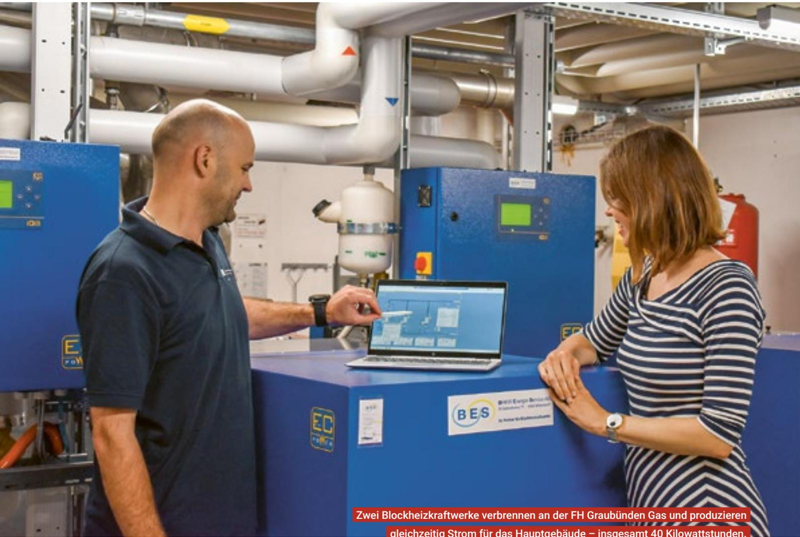
Zwei Blockheizkraftwerke verbrennen an der FH Graubünden Gas und produzieren gleichzeitig Strom für das Hauptgebäude – insgesamt 40 Kilowattstunden.
