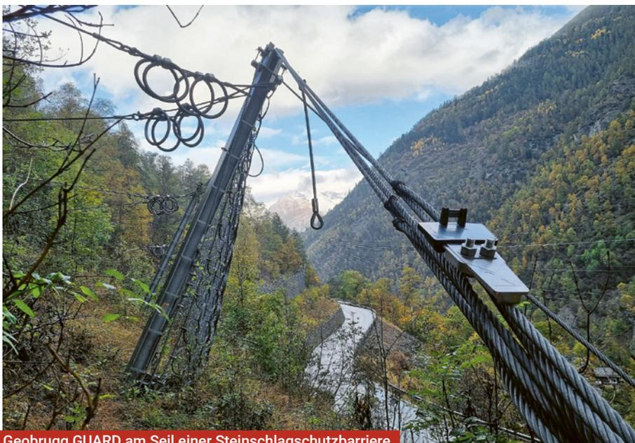
Geobrug GUARD am Seil einer Steinschlagschutzbarriere.
