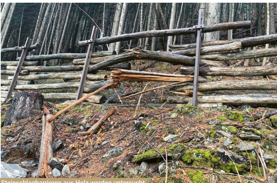
Steinschlagbarrieren aus Holz werden untersucht
