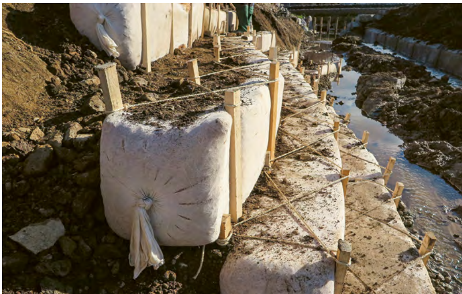
Abb. 2: Installation von Holzwolle-Faschinen bei einer Gewässerrenaturierung in Stabio (TI).
